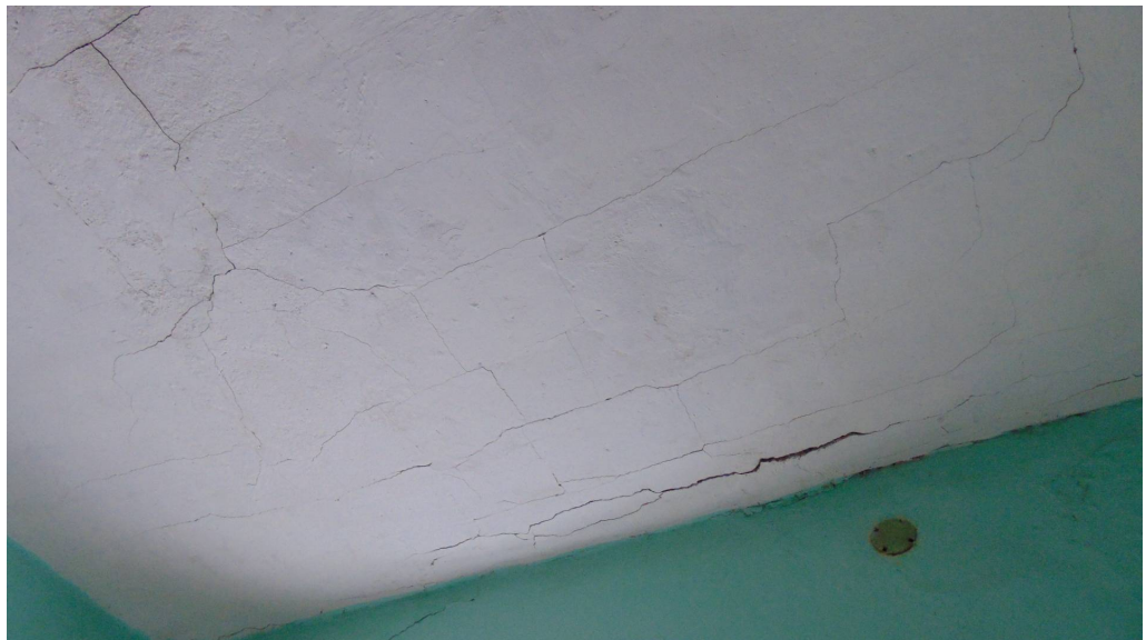
Spękania stropu
