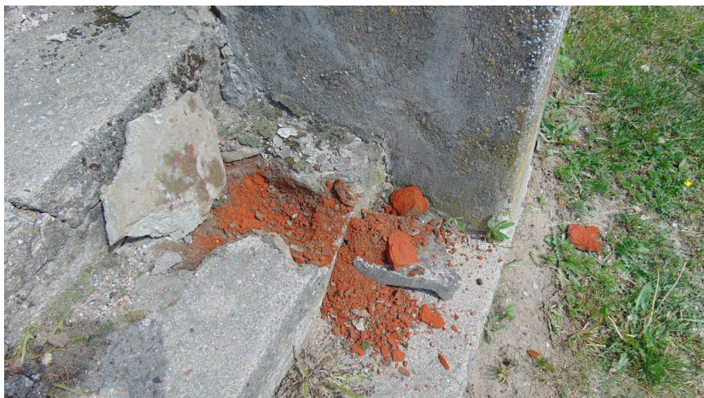
Zniszczone schody zewnętrzne
