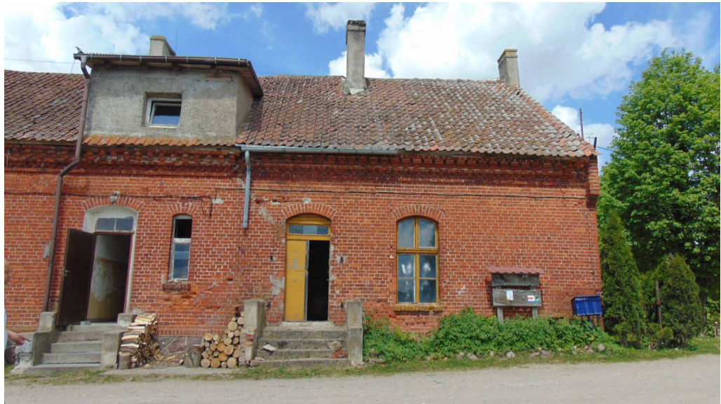
Widoczne braki rur spustowych, rynien i obróbek bacharskich
