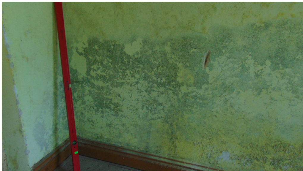
Zawilgocenie i pleśń na ścianach
