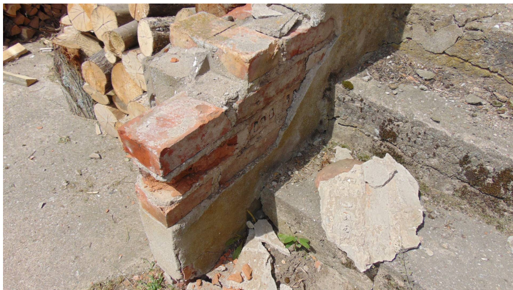
Zniszczone schody zewnętrzne
