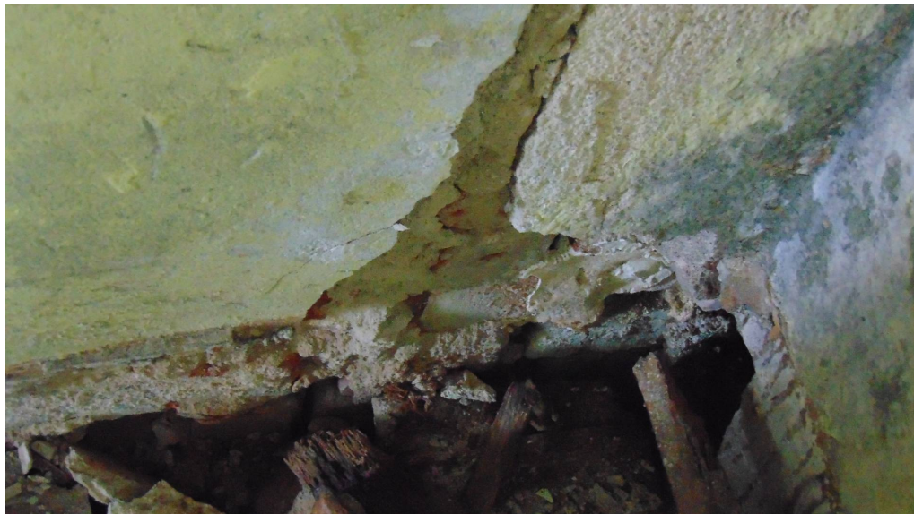
Spękania ścian wewnątrz budynku
