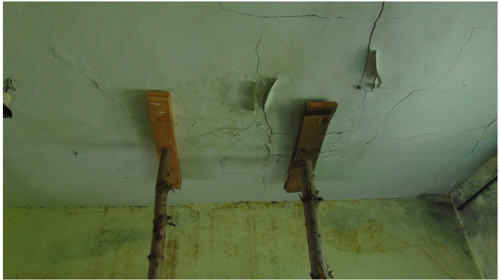
Ugięcie i spękania stropu
